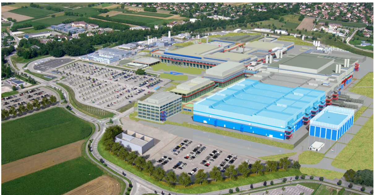
Site de STMicroelectronics à Crolles avec les agrandissements prévus
