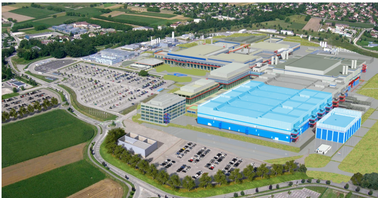
1. Site de STMicroelectronics à Crolles avec les agrandissements prévus
